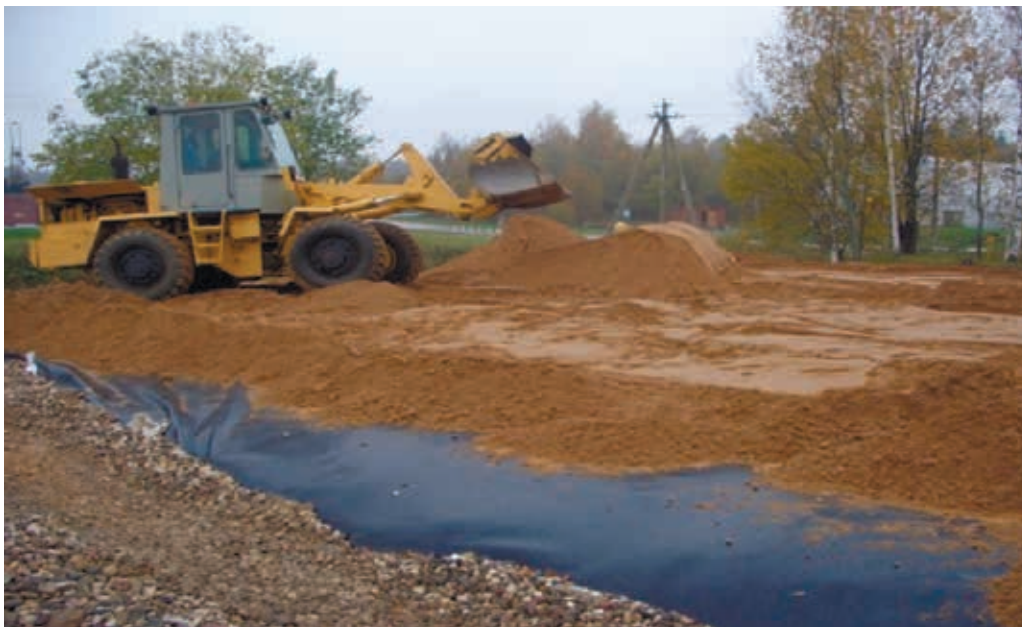
Послойное устройство покрытия ХТО. Укладка глины
