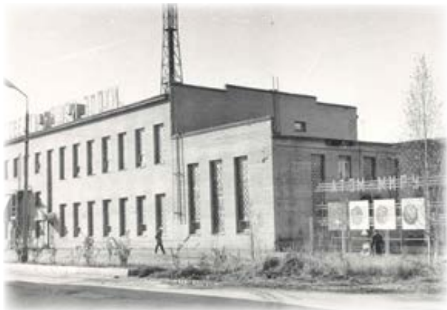
Главный технологический корпус (ГТК)
