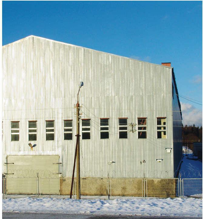
Хранилище РАО ГУП МосНПО «Радон» Radwaste temporary storage facility at Radon Moscow
