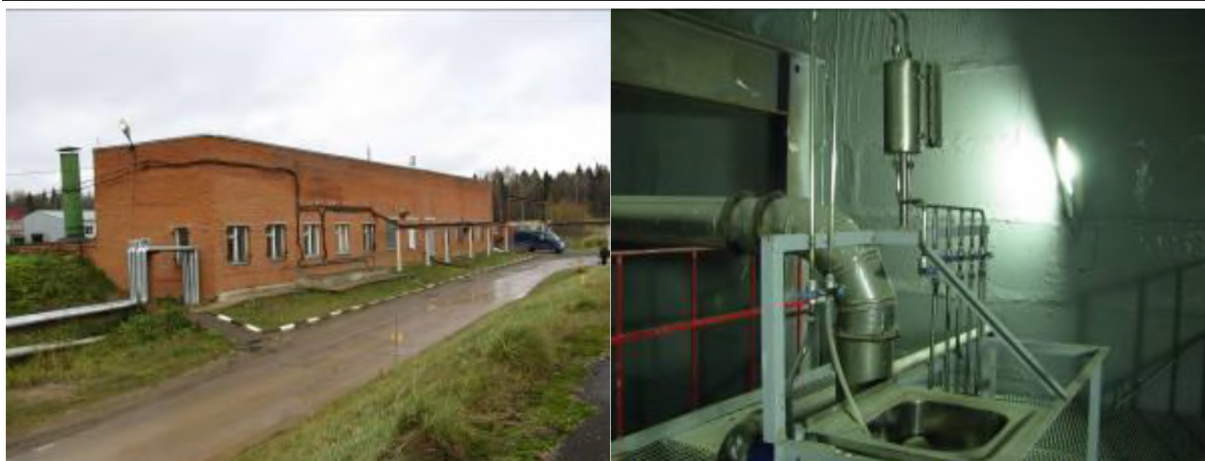
Рисунок 4.1.1.9 - Здание № 68. Хранилище жидких отходов (ХЖО № 1)
