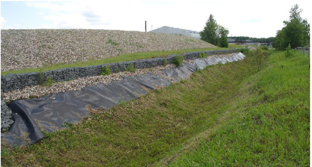
Рисунок 4.1.1.5- Хранилище РАО с усиленным защитным покрытием и дренажной системой
