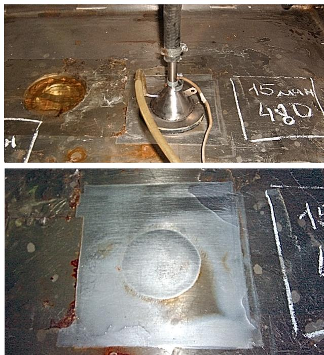
Рис. 2. Дезактивация «горячего» пятна круглой присоской (внизу – поверхность после дезактивации)
