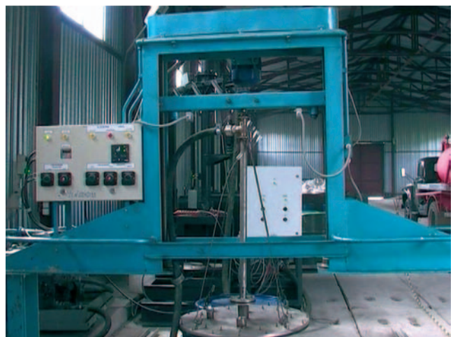
Рис. 2. Установка цементирования пропиткой ТРО в бочках 100 л и 200 л Fig. 2. Impregnation treatment plant for waste pre-loaded into 100 l and 200 l drums
