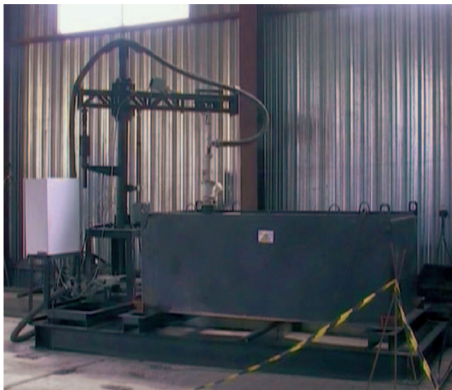
Рис. 3. Установка цементирования пропиткой ТРО в контейнерах марки КРАД Fig. 3. Impregnation treatment plant for waste pre-loaded into KRAD casks
