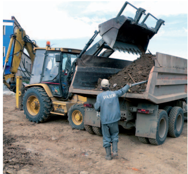
Вывоз радиоактивного грунта Extraction of radioactive soil
