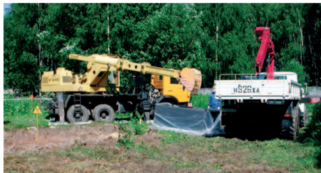
Деактивационные работы в Московской области Decontamination activities in the Moscow region
