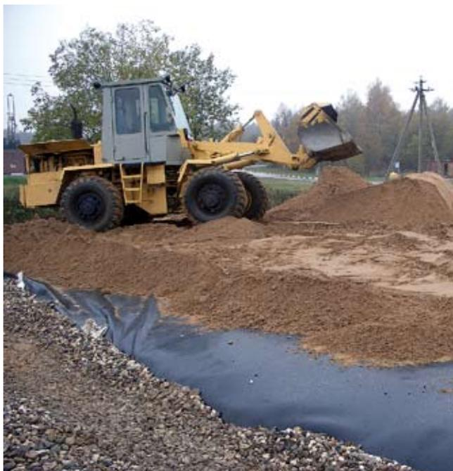
Формирование дренажных и изолирующих слоев защитного покрытия хранилища РАО
