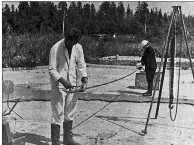
△ Ручное бурение разведочных скважин. 60-е годы
