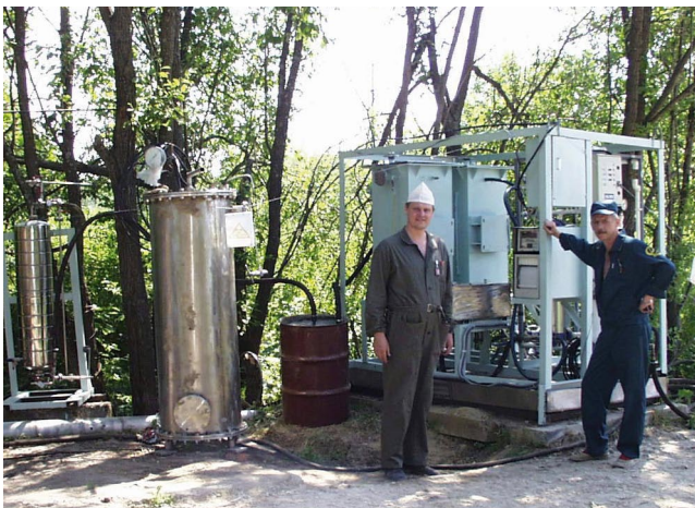
△ Испытания обратноосмотического модуля установки «Аква-Экспресс» в Научно-производственном комплексе. 1999 год
