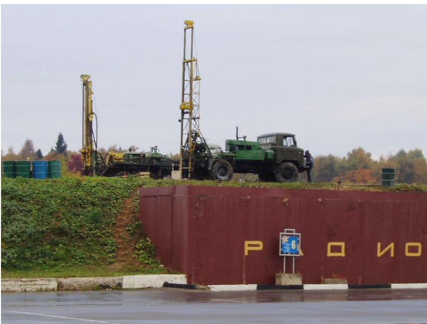
△ Повторное омоноличивание массива радиоактивных отходов
