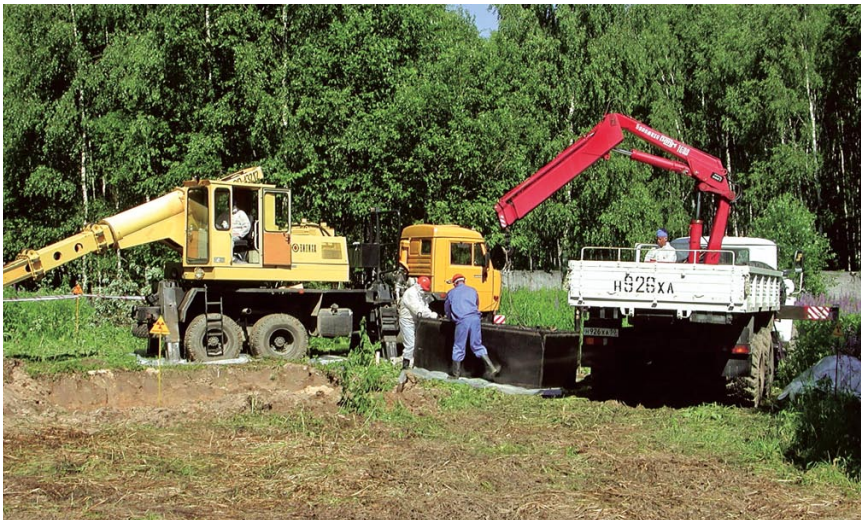
△ Использование манипулятора повышает безопасность при погрузке РАО
