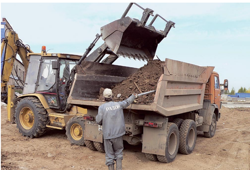
△ При дезактивации загрязненного грунта поверхностный слой снимают и отправляют на переработку
