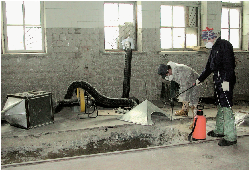
△ Дезактивация очага радиоактивного загрязнения в помещении цеха №14 ОАО «Кольчугцветмет»
