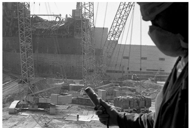
▽ Дозиметрический контроль в районе 4-го энергоблока Чернобыльской АЭС, 1986 г. / Radiological monitoring in the area of Unit 4 of the Chernobyl NPP, 1986
